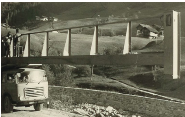
1965: Aufbau der Seilbahn zum KRISTALLQUARZIT – damals größte Materialseilbahn Südtirols: 1.750 m Länge, 550 Höhenmeter und 2.500 kg Traglast
