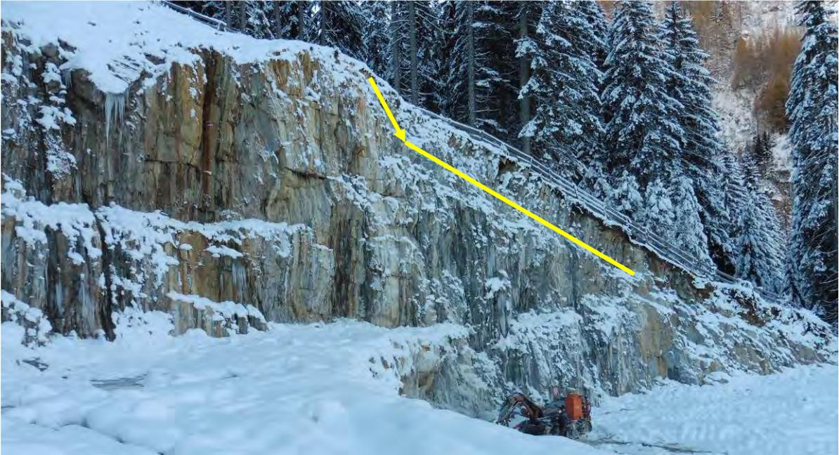
**Abb.10. oberflächliches Toppling, das von einer aus dem Hang herausfallenden Kluft (gelbe Linie) begrenzt wird.**
